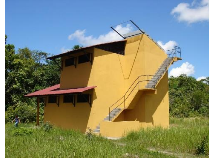
Figura 6 - Prédio do gaseificador.
